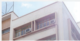
西貢街 (油尖旺) 中華電力有限公司物業 Saigon Street (Yau Tsim Mong) CLP Property
