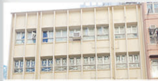
德華街 (荃灣) 中華電力有限公司物業 Tak Wah Street (Tsuen Wan) CLP Property
